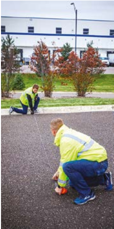
Традиционный метод: Требуется разметочный шнур, мел и 2 рабочих
