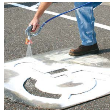
Нанесение разметки с помощью трафарета
